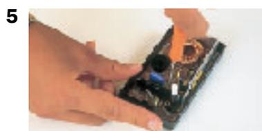
5. Raccorder le nouveau variateur en connectant les fils en fonction des indications portées sur l'appareil.
