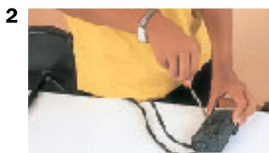
2. Démontez le variateur en dévissant les vis d'assemblage du boîtier.
